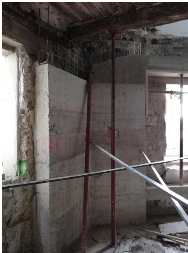
Travaux de reprise structurale. 2023 12 21.
