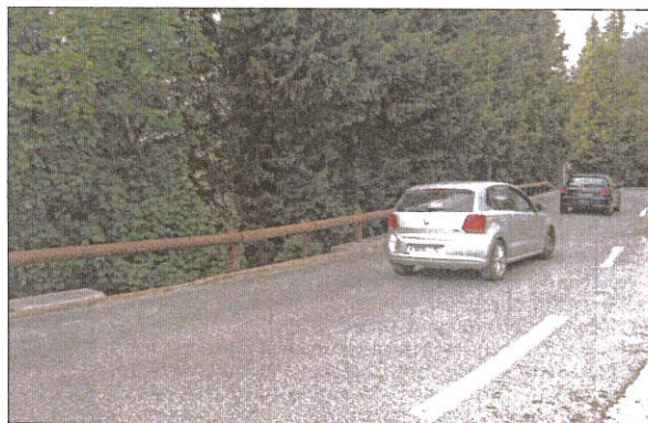
La glissière de sécurité a été installée sur 250 m, le long de la route départementale 4.
