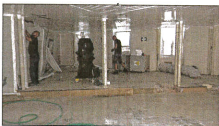
Le bâtiment connu pour avoir abrité le bazar Babali pendant des années, a également été la poste centrale de Grasse. Aujourd'hui, les travaux de désamiantage ont débuté par l'installation de salles étanches.
